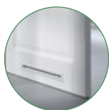
Respiradouros de passagem
